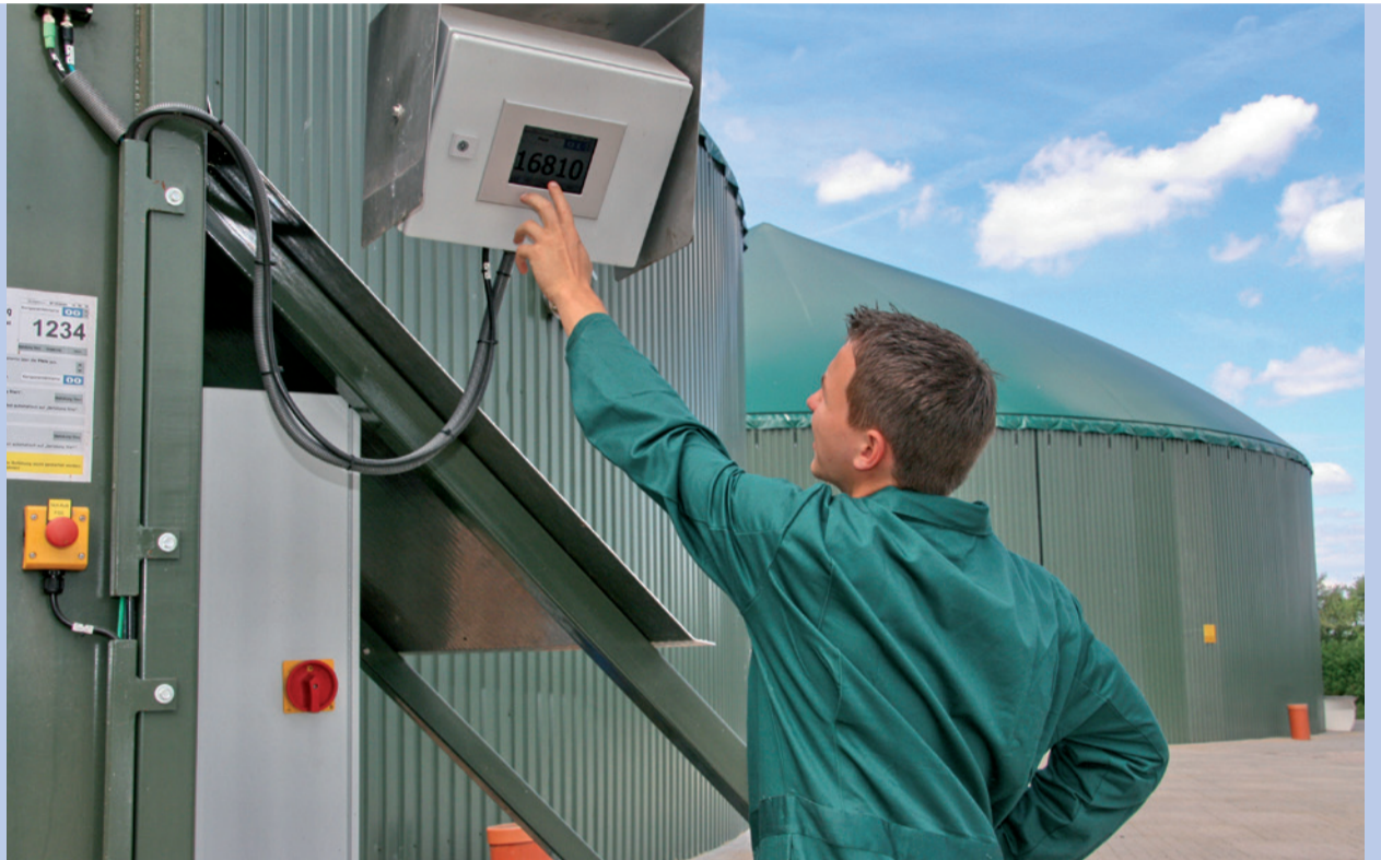
Biogas: Anspruchsvolle Elektronik sorgt für eine optimale Prozesssteuerung und einen stabilen Produktionsprozess.
